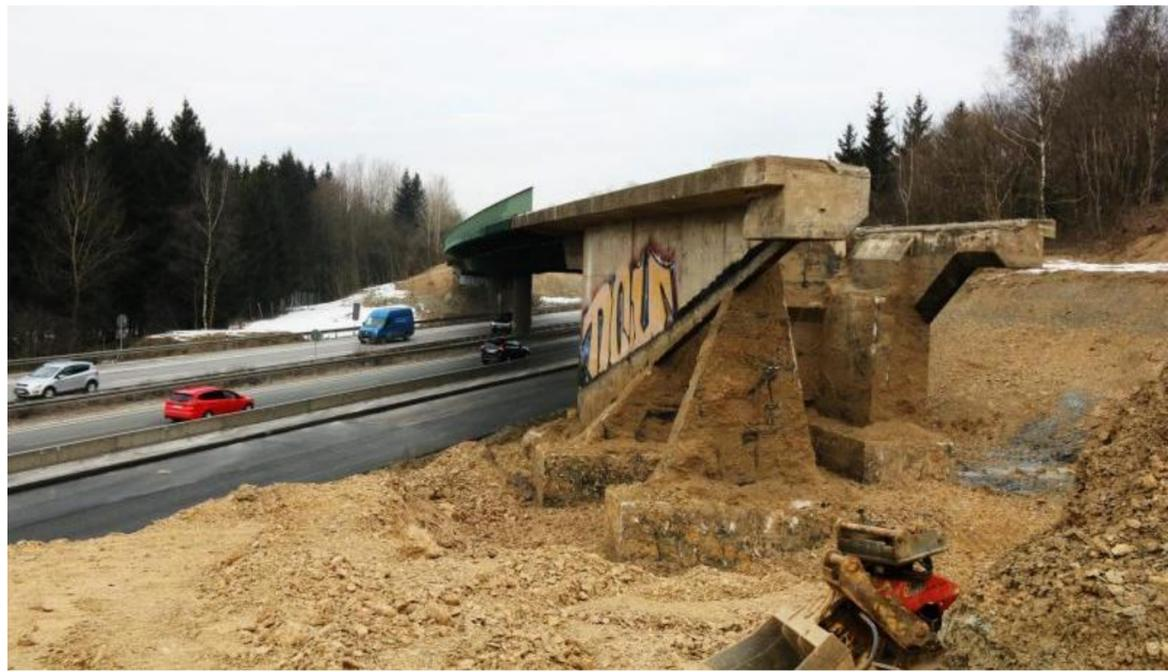
Die vorbereitenden Arbeiten sind abgeschlossen. Jetzt können die Kalteiche-Brücken über die Sauerlandlinie abgebrochen werden. Dafür ist eine Vollsperrung der Autobahn erforderlich. (Foto: Stadt Haiger)
