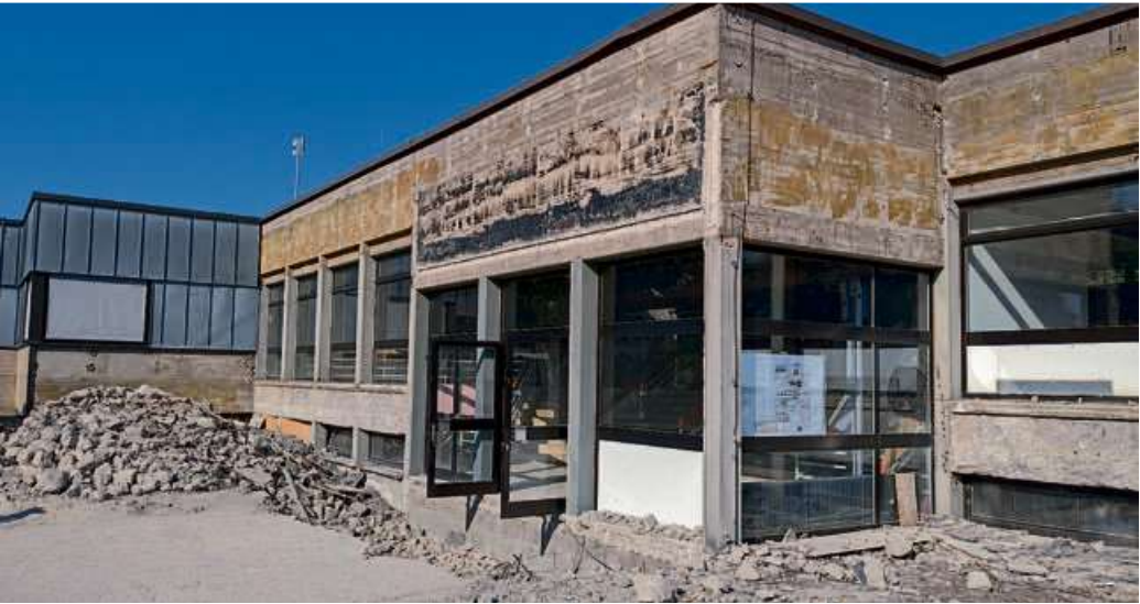
Da die Gastronomie vor das derzeitige Gebäude gesetzt werden soll, sind im Außenbereich umfangreiche Erdarbeiten erforderlich. Fotos: David Schleifenbaum/Stadt Haiger
