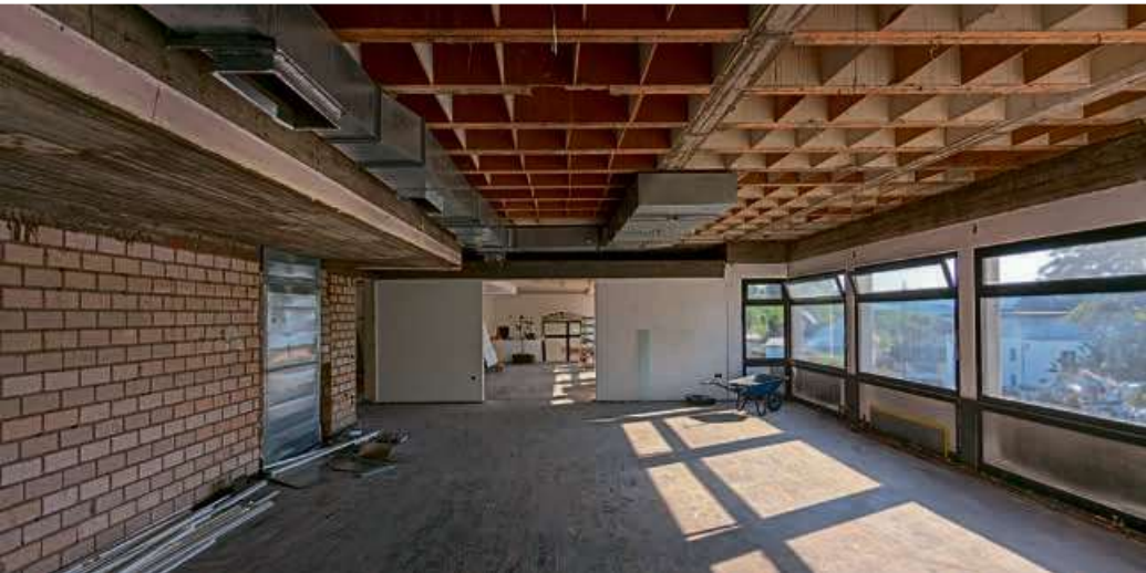
Die Räume wurden total „entkernt“ und können jetzt neu und zeitgemäß gestaltet werden.
