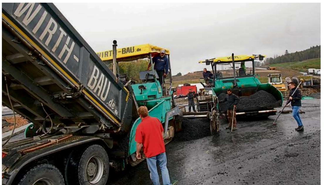
Gleich zwei „Fertiger“ waren auf der Kalteiche im Einsatz, um die Asphalt-schichten auftragen zu können. Rund 320 Tonnen der so genannten „Deckschicht“ wurden aufgetragen.
