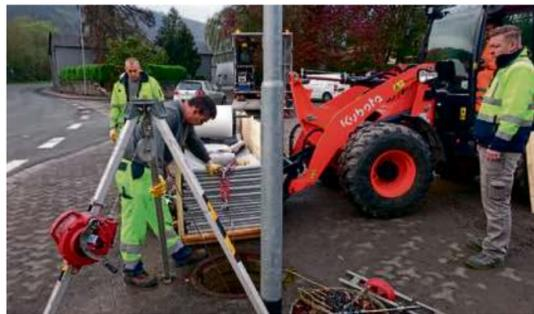
Aktuell wird die Sanierung der Abwassersammelleitungen ausgeführt. Foto: Stadt Haiger
