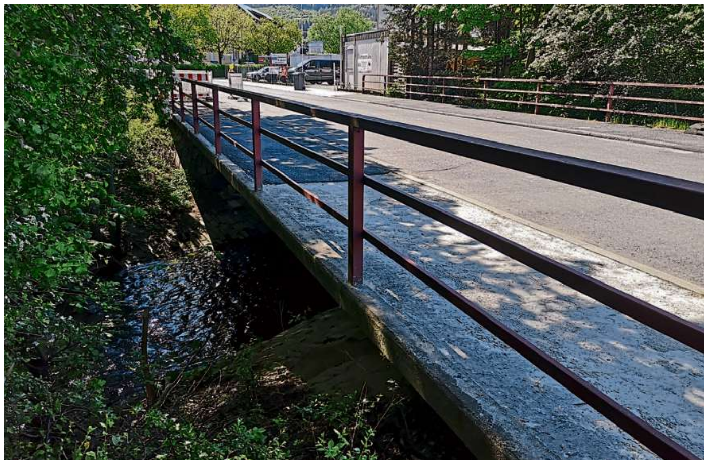
Die Brücke über den Aubach in der Haigerer Reierstraße muss grundhaft erneuert werden. Die Arbeiten werden etwa 12 Wochen dauern und rund 220 000 Euro kosten. Foto: Ralf Triesch/Stadt Haiger
