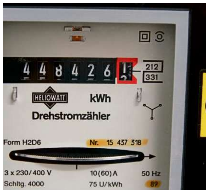
Stromzähler werden gewechselt.
