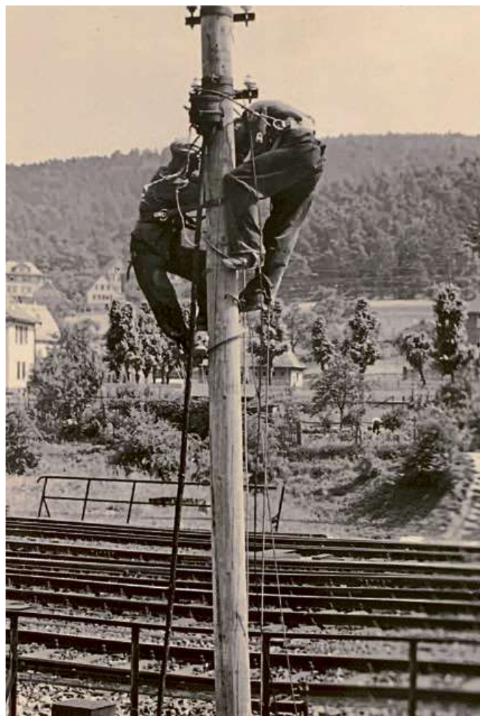
Unmittelbar nach dem Krieg begann die Stadt mit der Beseitigung der Schäden - das elektrische Netz musste fast komplett erneuert werden. Foto: Krumm/Archiv der Stadt Haiger
