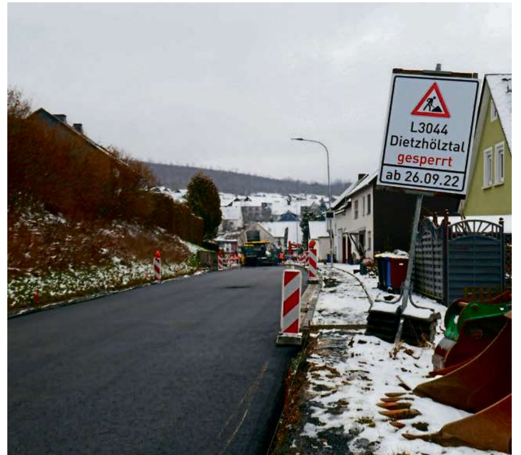
Ein Foto von Anfang März - mittlerweile ist dieser Bauabschnitt abgeschlossen, die Arbeiten wechselten in den zweiten Abschnitt. Foto: Thilo Becker
