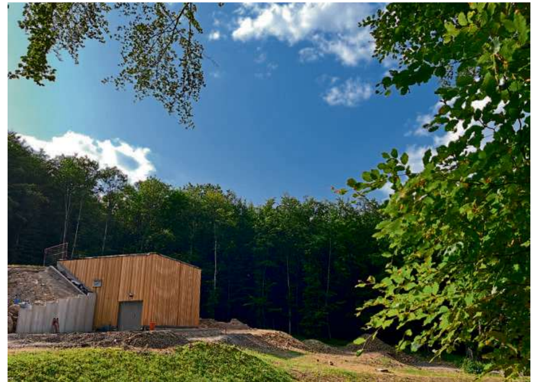
Der neue Hochbehälter wurde auf dem Speichelsberg - oberhalb von Langenaubach Richtung Rabenscheid - errichtet. Er fasst 600 Kubikmeter Wasser - dreimal so viel wie der tägliche Durchschnittsverbrauch Langenaubachs.
