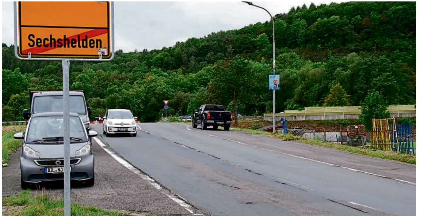
Hier beginnen die Bauarbeiten: Zunächst kommt der Bereich zwischen dem Kreisverkehr auf der B 277 und der Einfahrt zur Firma „Oranier“ an die Reihe. Foto: Ralf Triesch/Stadt Haiger
