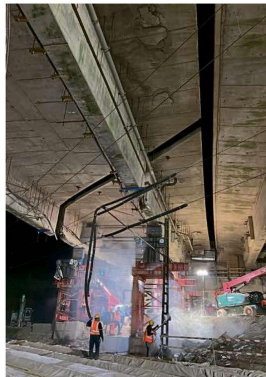
Das letzte über der Bahn befindliche Brückenteil wurde während einer Sperrpause der Deutschen Bahn herausgeschoben. Foto: Autobahn Westfalen
