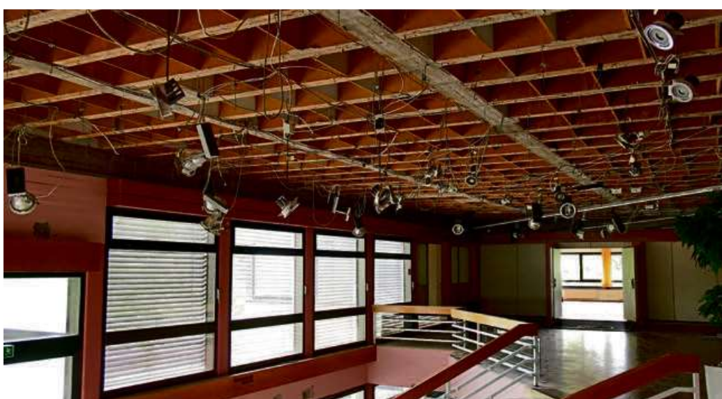
Die Entkernung des Altbaus hat bereits begonnen.
