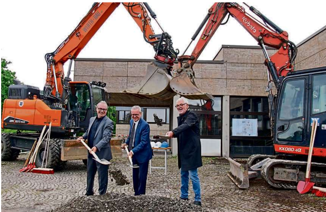
Los geht's: Bürgermeister Mario Schramm (Mitte), Stadtverordnetenvorsteher Bernd Seipel (r.) und Fachplaner Martin Berg vom Büro „HMP Architekten“ aus Köln beim offiziellen Spatenstich zur Stadthallensanierung und dem Neubau eines Restaurants.
