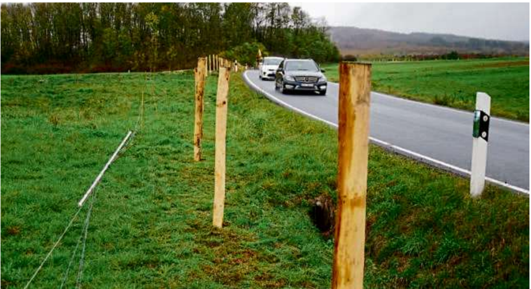
Der Bau eines 60 Kilometer langen Zauns zum Schutz vor der Schweinepest (ASP) hat an der Kreisstraße 49 bei Sechshelden begonnen. Derzeit werden die Zaunpfiler eingerammt, links im Bild ist der „taktische Elektrozaun“ zu sehen. Foto: Ralf Triesch/Stadt Haiger
