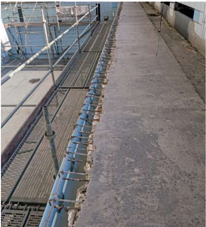
Von den Sanierungsarbeiten betroffen ist der komplette, insgesamt 66 Meter lange Rand des Schwimmbeckens.
