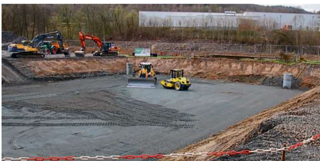
Die Bauarbeiten unterhalb der bestehenden Kläranlage haben im Januar begonnen.
