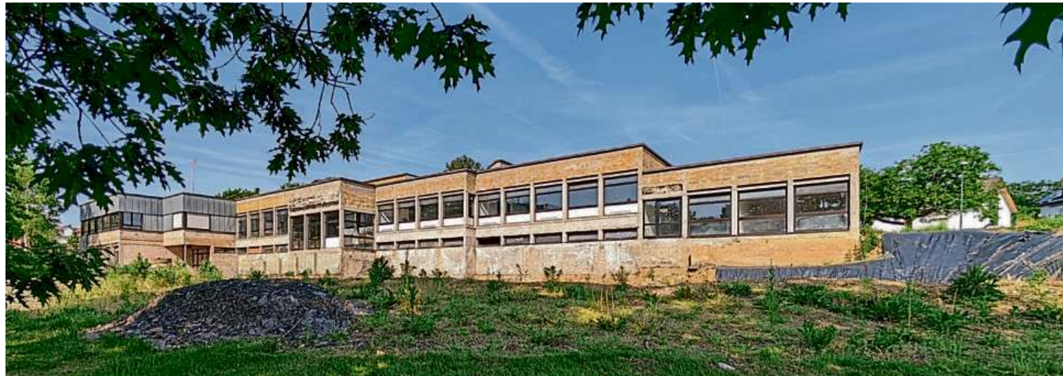
Die Arbeiten an der Stadthalle in der Haigerer Goethestraße gehen weiter.
