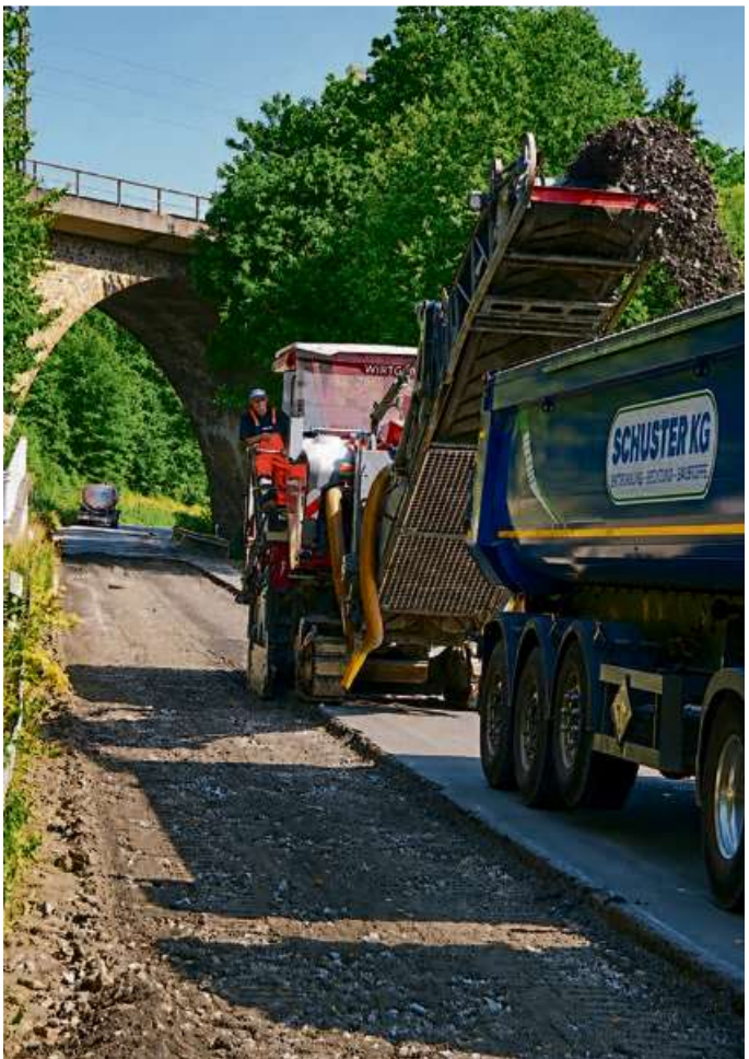
Auf der Landesstraße 3442 zwischen Rodenbach und Fellerdilln wird gerade die Asphalttschicht abgefräst.
