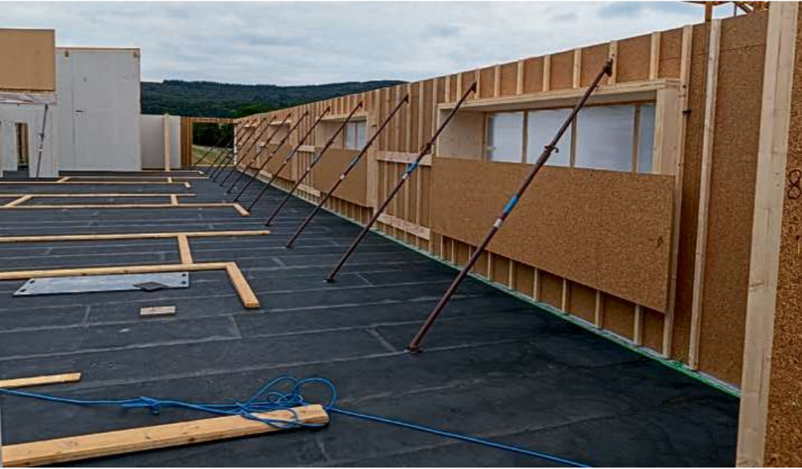
Das Gebäude entsteht in Holzrahmen-Bauweise.
