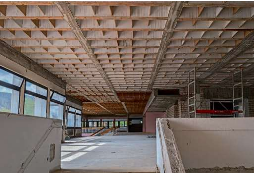
Im Zuge der Abbrucharbeiten erfolgen gleichzeitig statische Ertüchtigungsmaßnahmen. Foto: David Schleifenbaum/Stadt Haiger
