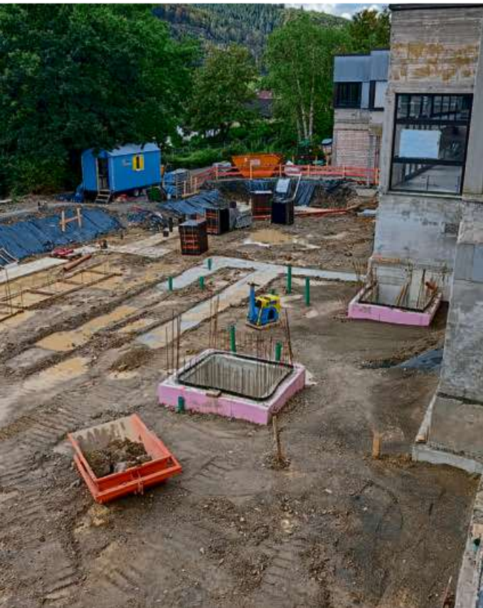
Im Außenbereich der Stadthalle wird der Restaurantneubau vorbereitet. Foto: David Schleifenbaum/Stadt Haiger
