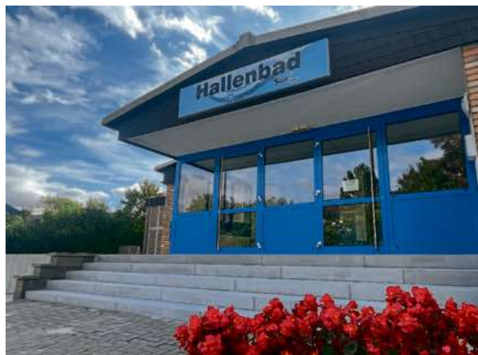
Im Eingangsbereich wurde ein barrierefreier Zugang gebaut, der über die Parkflächen erreichbar ist.
