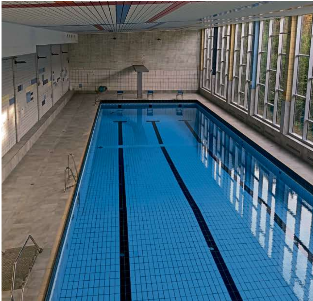
Das Haigerer Hallenbad nach der umfangreichen Sanierung.
