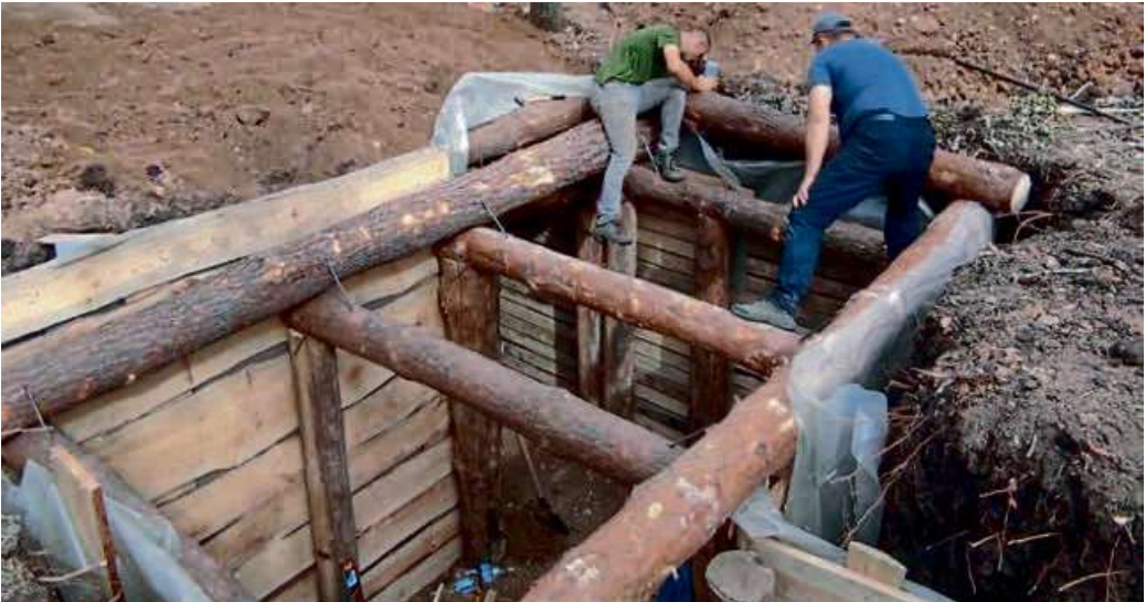
Während historische Verteidigungsanlagen in Deutschland heute vor allem an vergangene Konflikte erinnern, werden in der Ukraine weiterhin Schutz- und Verteidigungsanlagen errichtet, die Menschenleben retten und Städte schützen sollen. Bürgermeister Amons und sein Team reisen dafür immer wieder an die Front, um beim Bau solcher Anlagen zu unterstützen und andere Maßnahmen zur Verteidigung zu errichten. Foto: Amons
