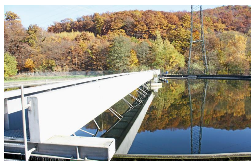
Die Kläranlage in der Haigerer „Ebbenau“ muss zweistraßig ausgebaut werden. Die Stadt hat im Haushaltsentwurf eine Million Euro für den Start der Baumaßnahme vorgesehen. (Foto: Stadt Haiger)
