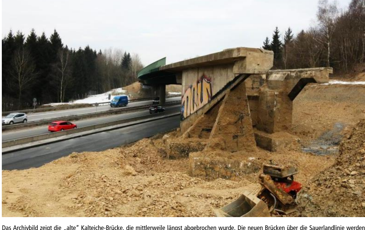
Das Archibild zeigt die „alte“ Kalteiche-Brücke, die mittlerweile längst abgebrochen wurde. Die neuen Brücken über die Sauerlandlinie werden erst im neuen Jahr „eingehoben“. (Foto: Triesch/Stadt Haiger)
