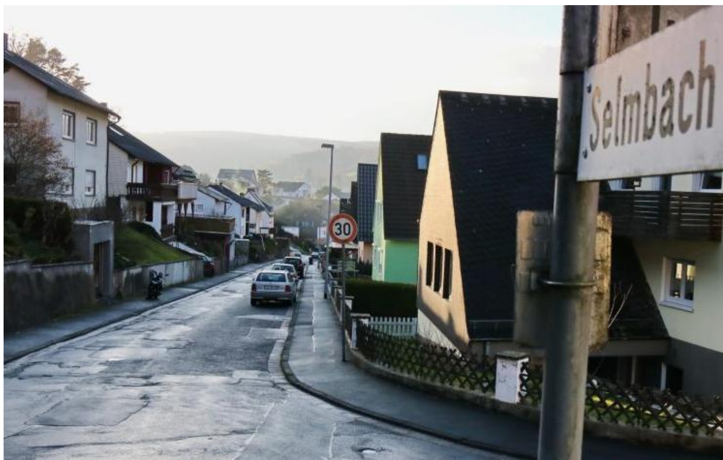
Die Selmbach-Straße in Langenaubach wird in diesem Jahr erneuert.
