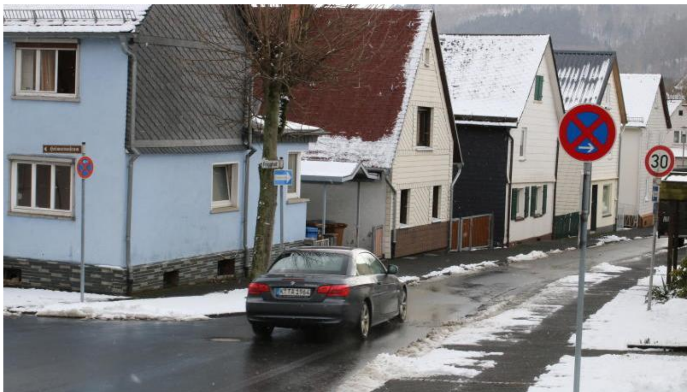
Die Fahrt durch die Mühlenstraße ist in der kommenden Woche von Montag bis Mittwoch nur bis zu dieser Stelle in Höhe des Ärztehauses möglich. Dann wird die Straße wegen Bauarbeiten voll gesperrt. Rathaus und Marktplatz sind weiter erreichbar. (Foto: Stadt Haiger)
