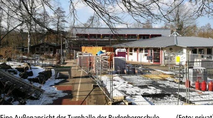
Eine Außenansicht der Turnhalle der Budenbergschule. (Foto: privat)
