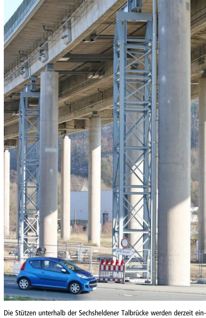
Die Stützen unterhalb der Sechsheldener Talbrücke werden derzeit eingebaut. (Fotos: Stadt Haiger)
