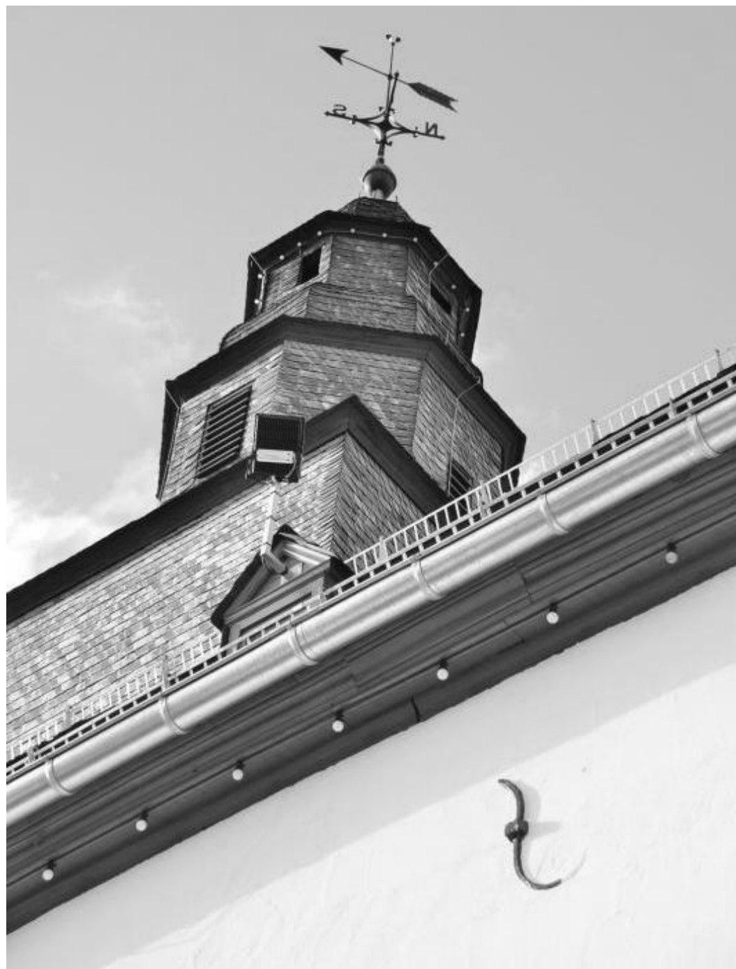
Die sanierte Oberroßbacher Kirche. (Foto: Daniel Hermann)
