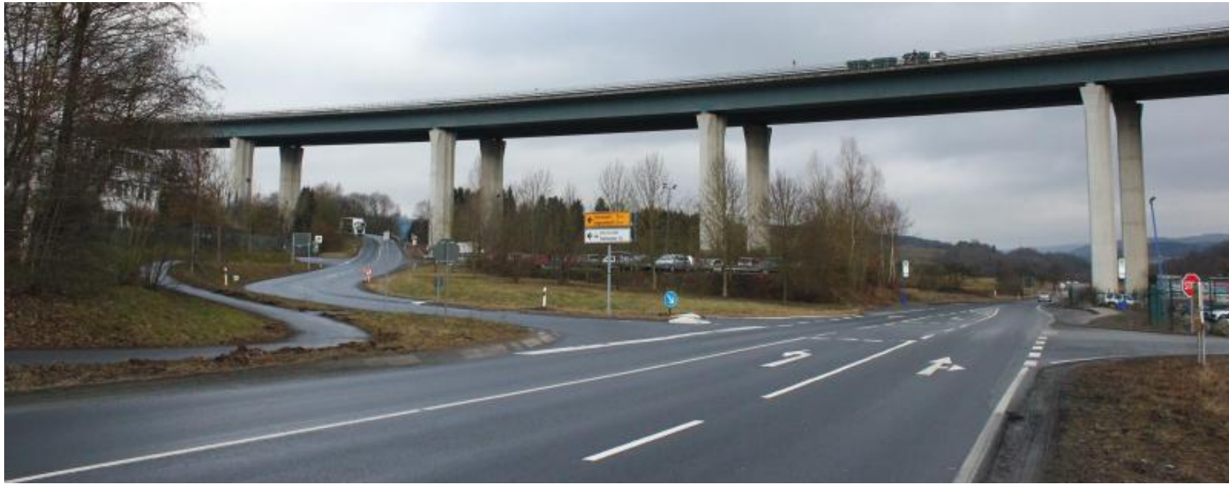
In Höhe der Firma „Kühne & Nagel“ beginnt die Kreisstraße 43 in Richtung Haigerseelbach und Steinbach. Die Straße wird saniert und etwa vier Wochen voll gesperrt.
