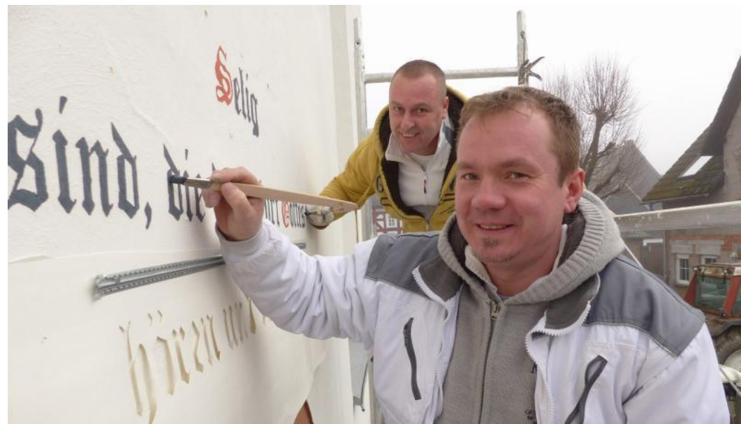
Kirche Oberroßbach erhält Ausmalung: Nach einer alten Vorlage malen Piotr Korol und sein Kollege Piotr Niekula (hinten) den Bibelspruch „Selig sind die Gottes Wort hören und bewahren“ (Lukas 11, 28) mit einer Schablone an die Kirchenwand. (Foto: Becker-von Wolff)
