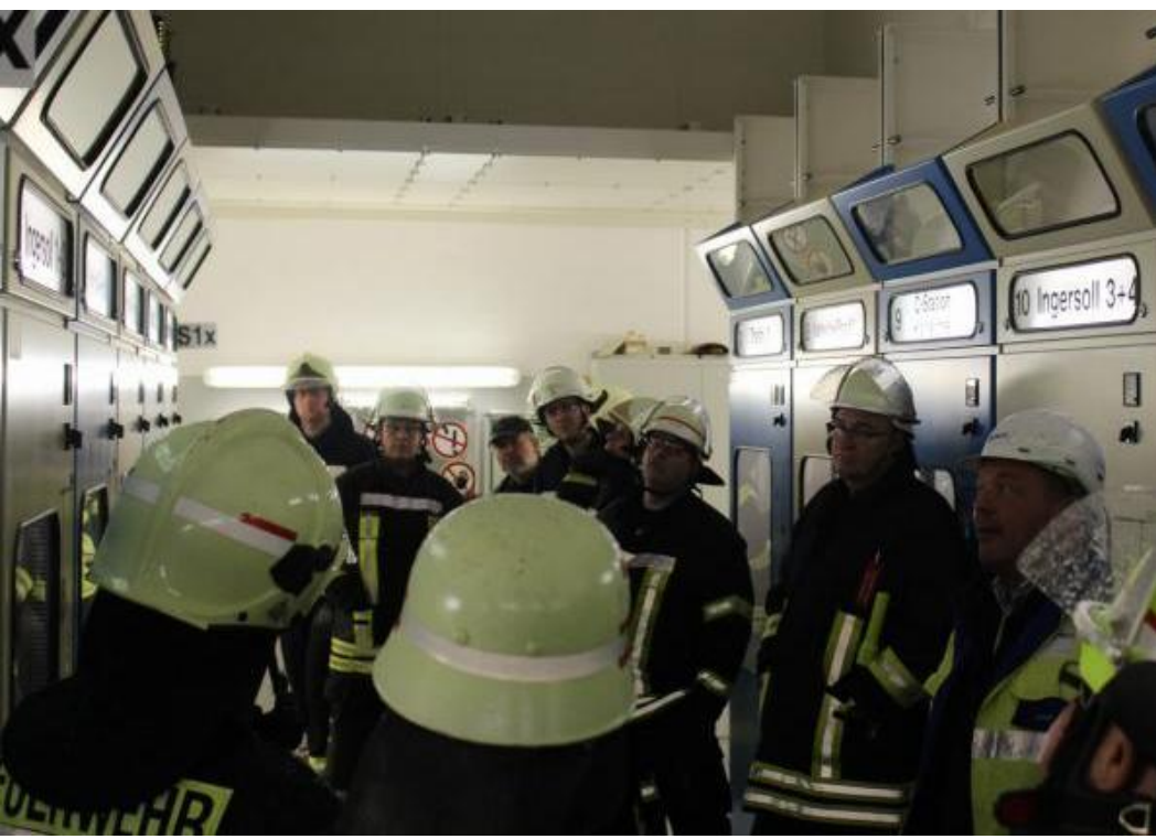
Die Mitarbeiter der Freiwilligen Feuerwehr bei der Unterweisung in der Umspannanlage Haiger-Kalteiche.
