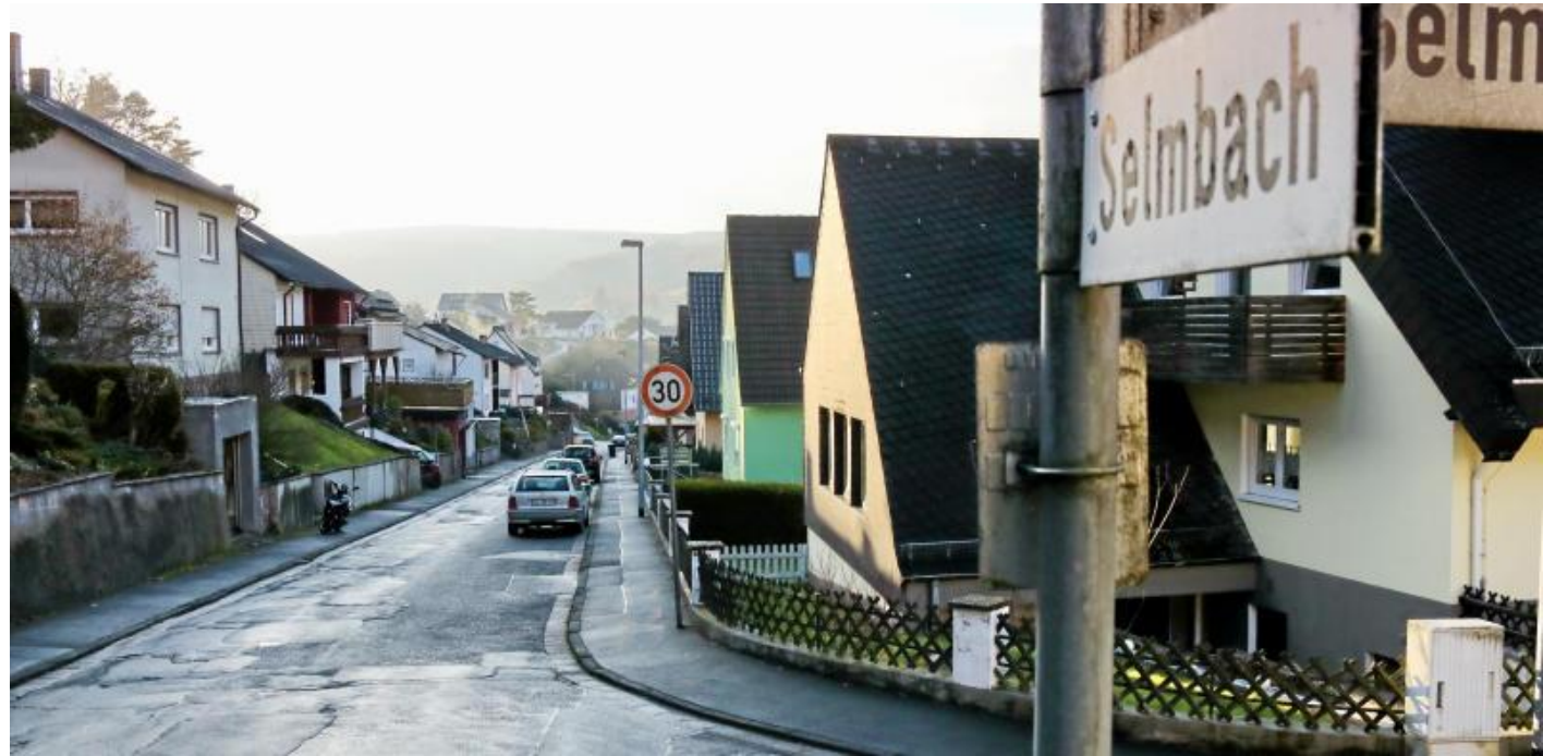
Die Straße „Selmbach“ in Langenaubach soll grundhaft erneuert werden. Die Maßnahme wird inklusive umfangreicher Arbeiten an der Kanalisation und Wasserleitung etwa 1,1 Millionen Euro kosten. (Foto: Stadt Haiger)
