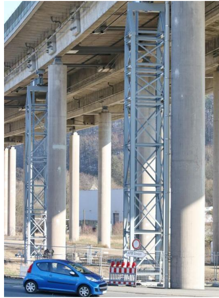
Die Sechsheldener Talbrücke.
