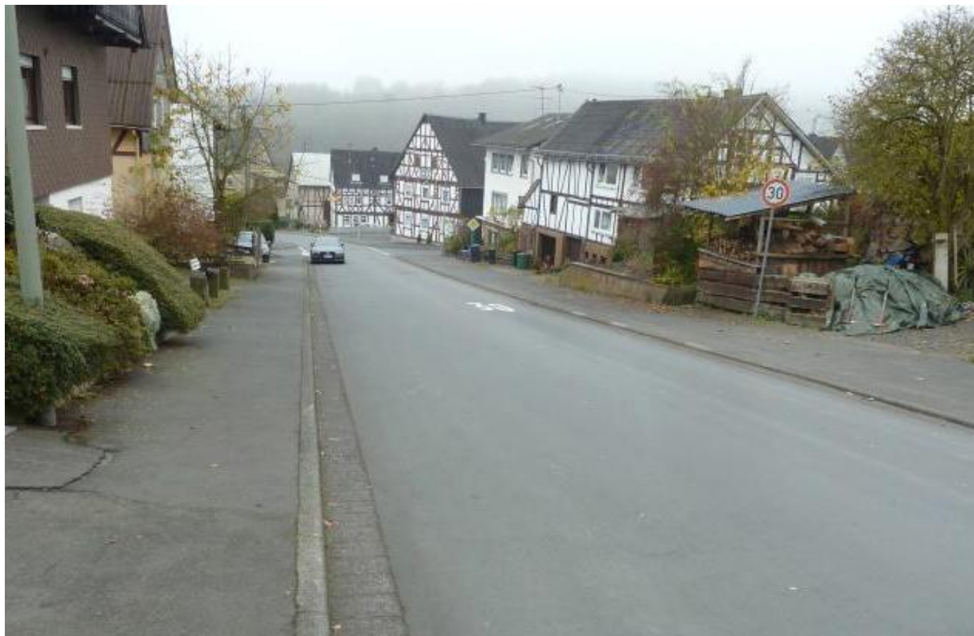
In der Allendorfer Wachenbergstraße muss der Kanal erneuert werden.
