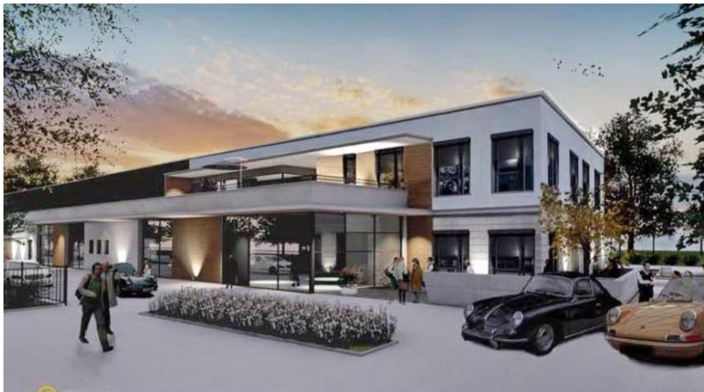
Auf der Kalteiche entsteht eine neue moderne „Young- & Oldtimer“-Garage samt zweigeschossigem Bürogebäude und angegliederter Eventfläche. Die Fertigstellung ist für Frühjahr 2019 geplant.
