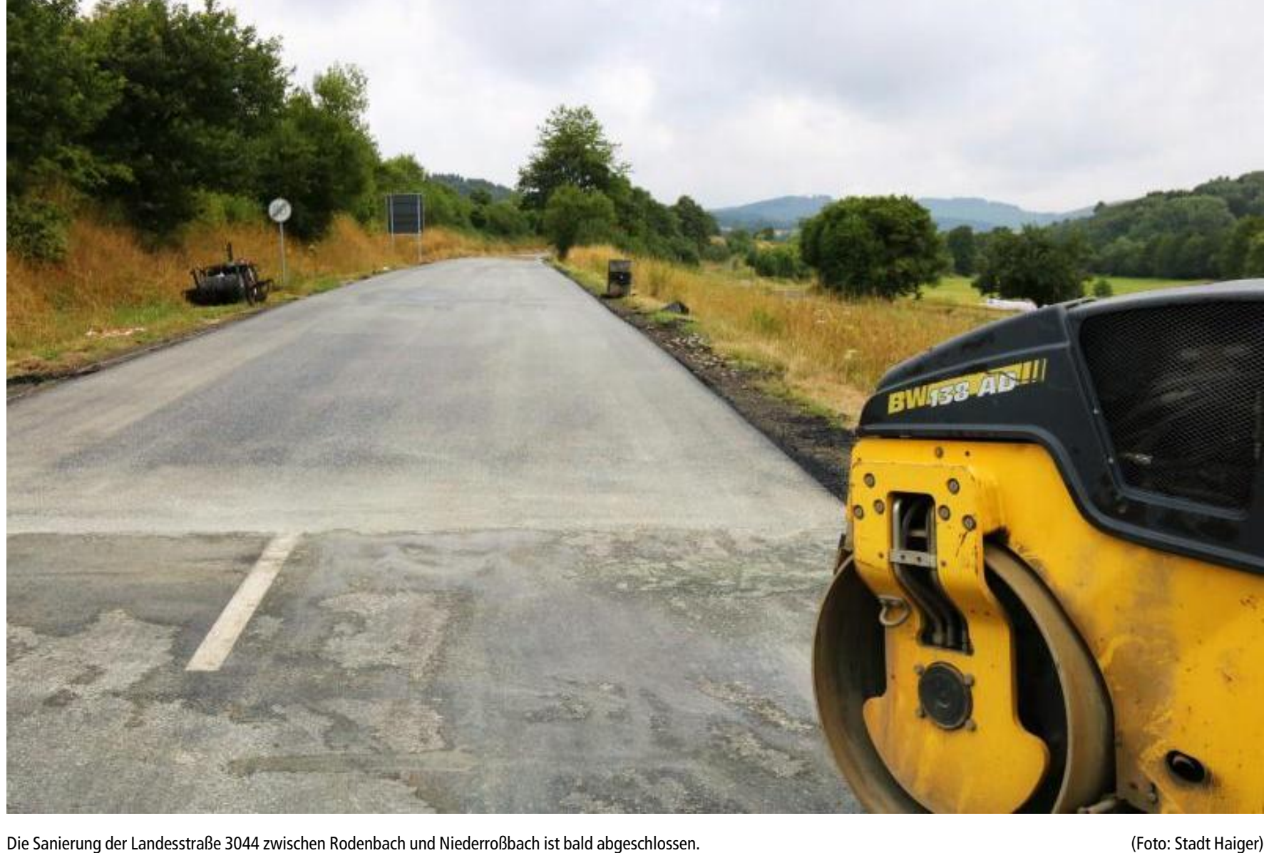
Die Sanierung der Landesstraße 3044 zwischen Rodenbach und Niederroßbach ist bald abgeschlossen.
