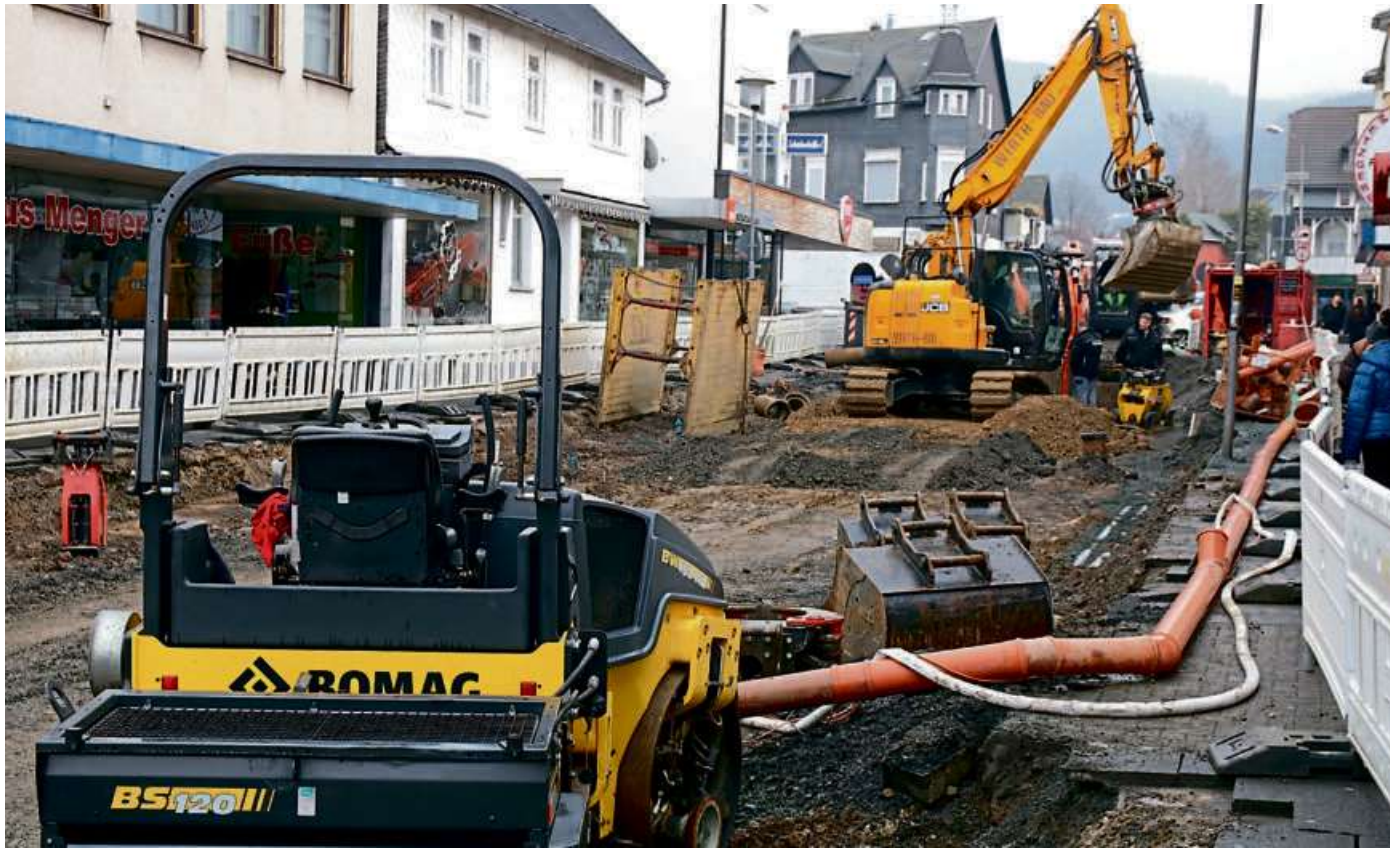
Die Arbeiten in der Hauptstraße laufen gut. Die Fachfirma profitiert von der milden Witterung. Fotos: Triesch/Stadt Haiger
