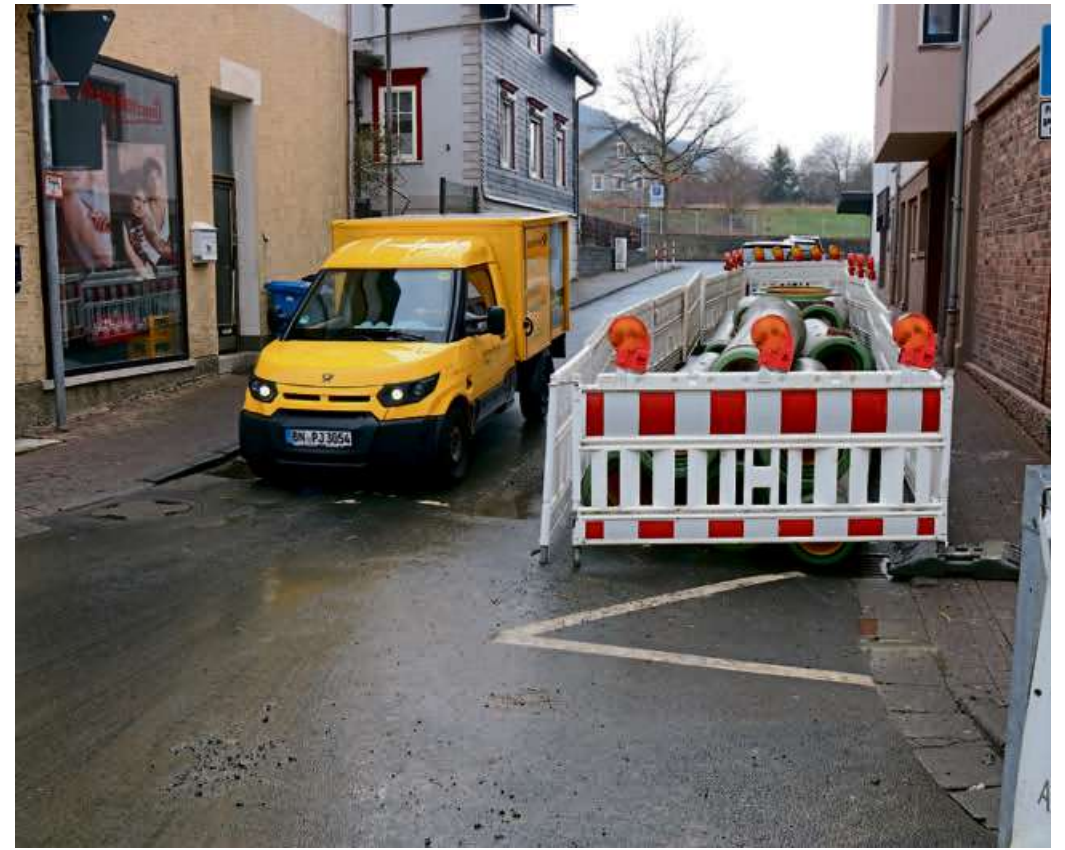
Da sich die Kanalbauarbeiten bis in die Burgstraße ziehen, musste diese gesperrt werden.
