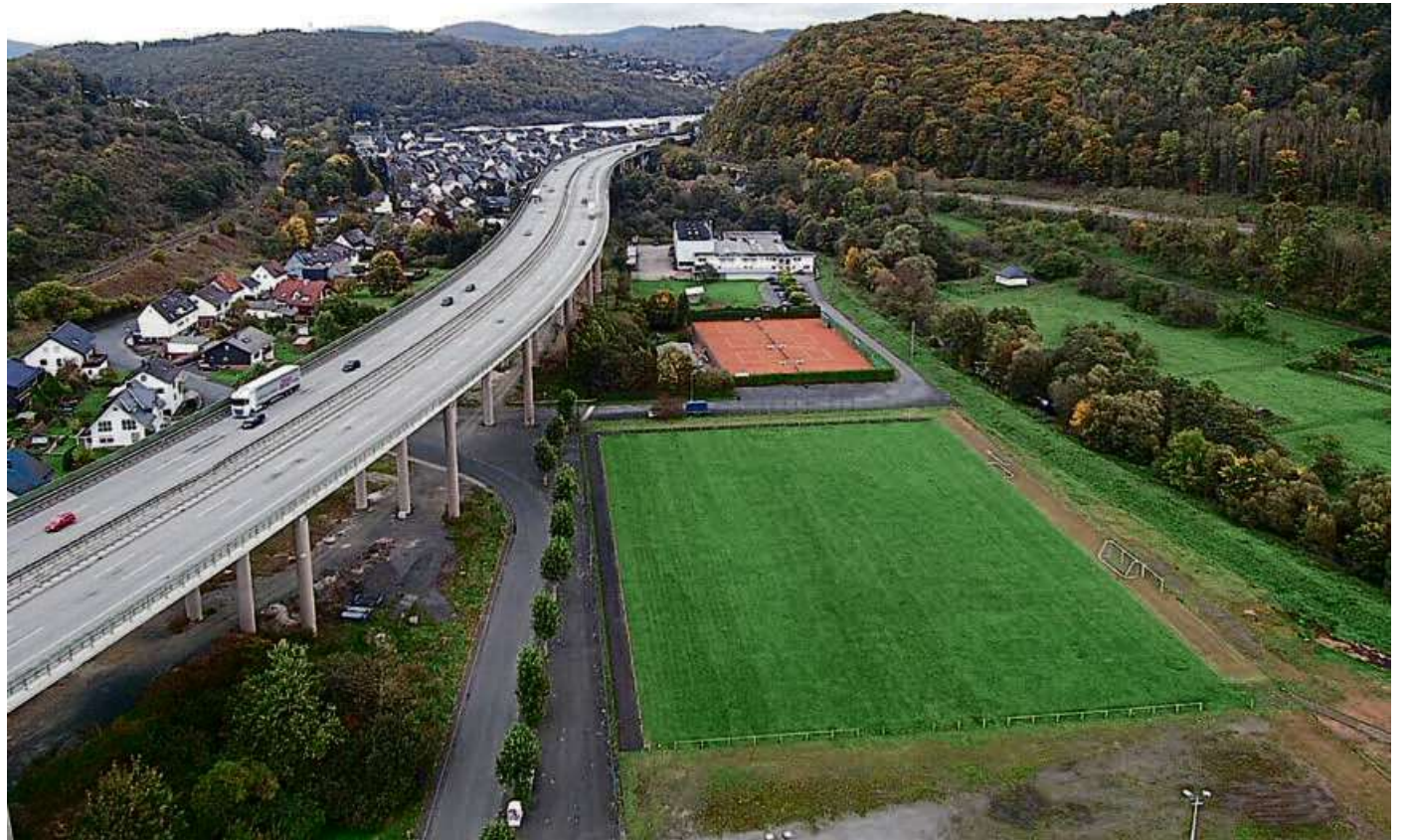
Die Talbrücke Sechshelden ist seit Jahrzehnten ein ortsbildprägendes Bauwerk.
