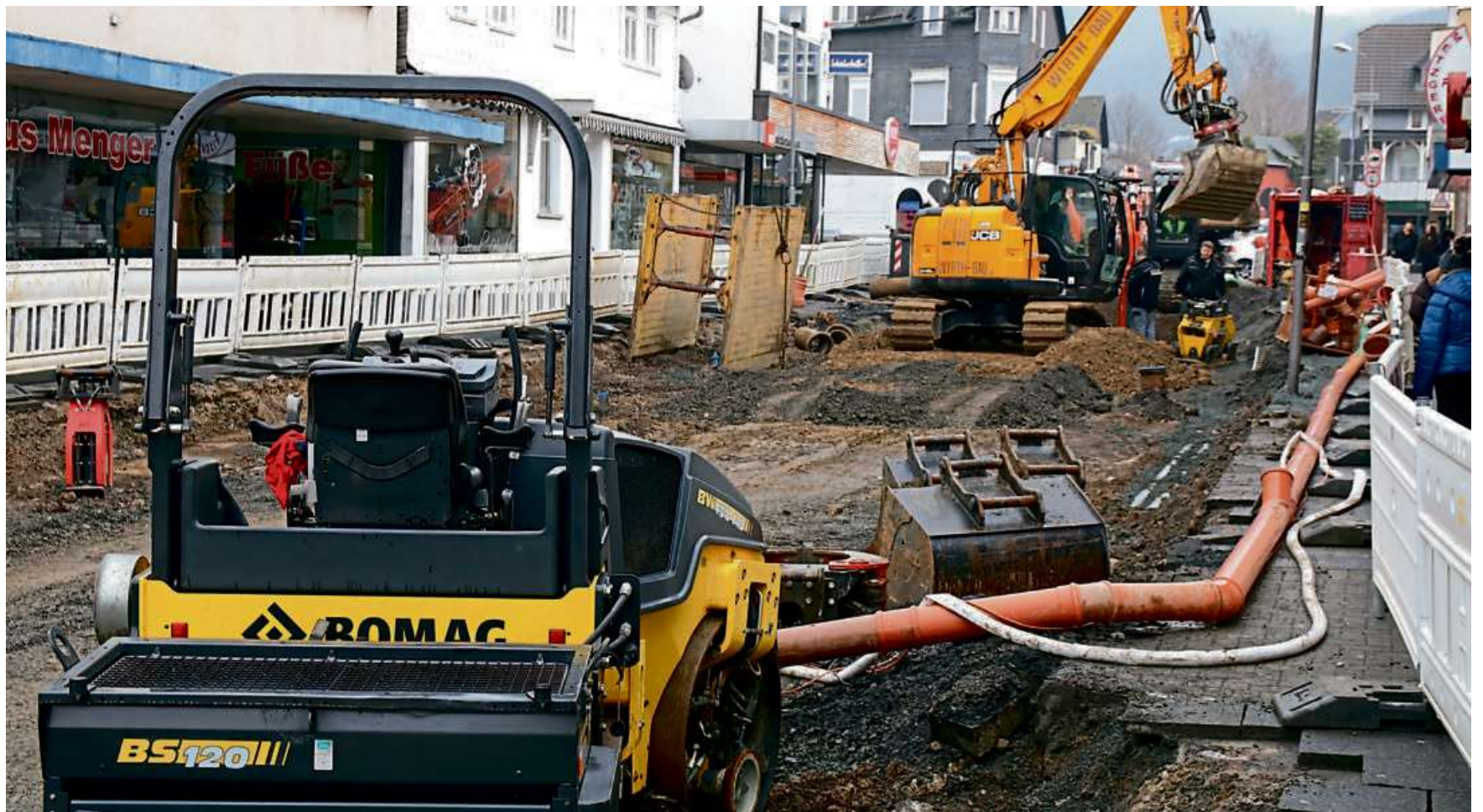
Die Untere Hauptstraße wird derzeit grundsaniert. Das ist einer der größten Haushaltsposten im Haigerer Etat für 2019.
