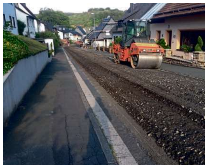
Auch im Selmbach in Langenaubach laufen umfangreiche Arbeiten.
