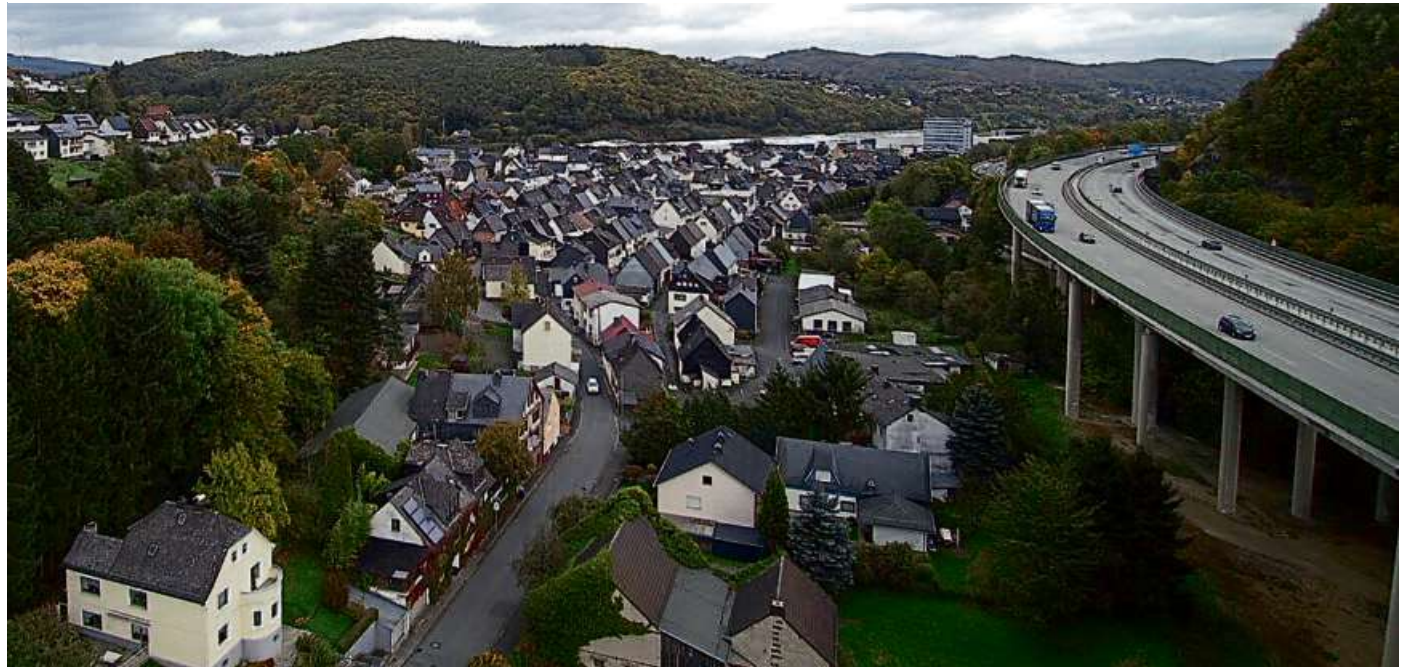
Die Talbrücke spannt sich über den Ort Sechshelden.
