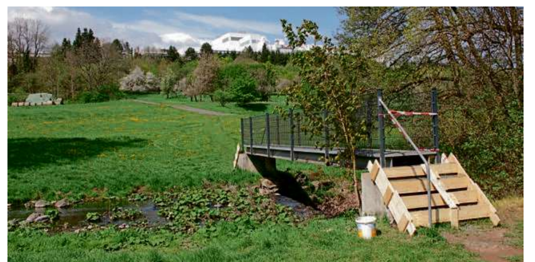
Das Stufenmaß der Brücke über den Aubach wurde angeglichen. Foto: Lea Siebelst
