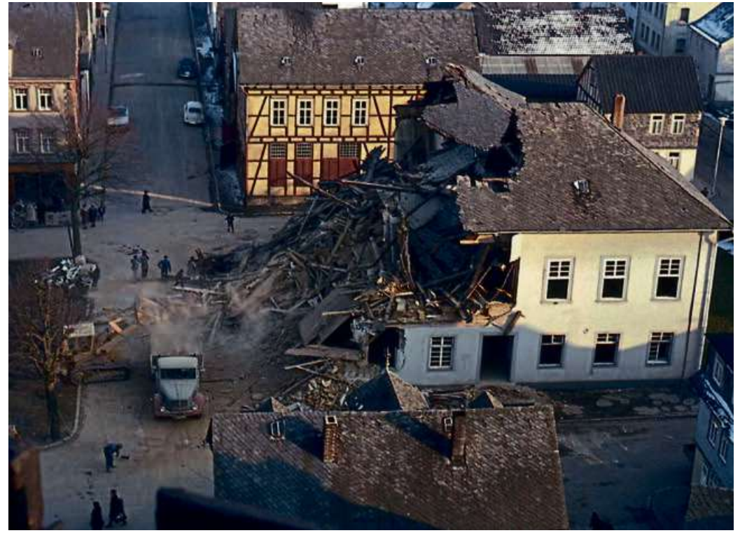
Abriss des „Stadthauses“. Dieses Gebäude wurde laut Bürgermeister Willi Kröckel „nur noch durch die Tapeten zusammen gehalten“. Foto: Archiv Stadt Haiger
