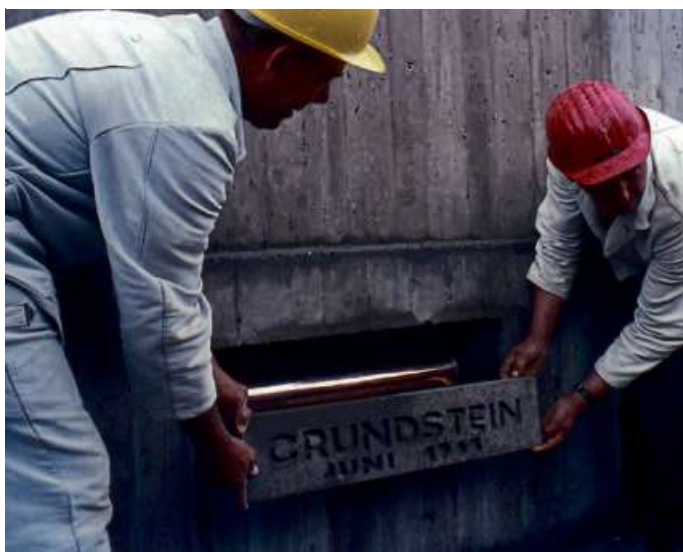
Grundsteinlegung im Juni 1968.
