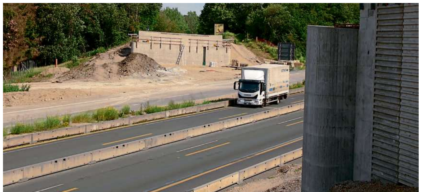
Die Fundamente stehen bereits. Jetzt muss nur noch die neue Brücke „eingehoben“ werden.
