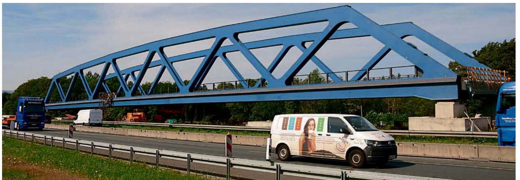
Die beiden Brücken sind 98 und 120 Meter lang und lagern derzeit am Rand der A45 in Fahrtrichtung Hanau. In Kürze werden sie unter Vollsperrung der Autobahn „eingehoben“.
