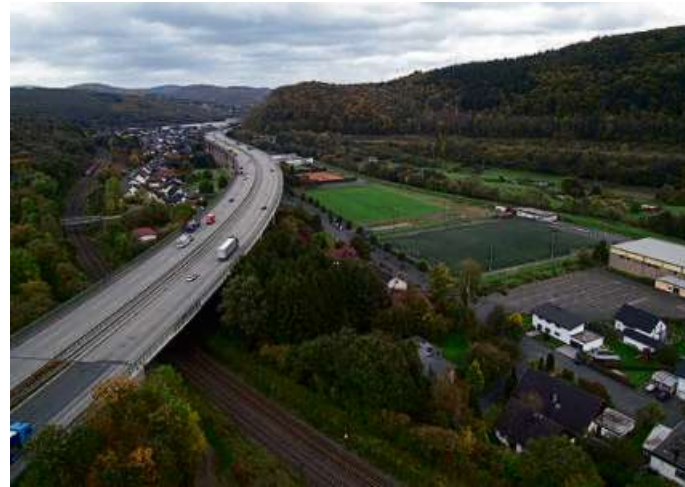
Die Talbrücke soll abgerissen und an gleicher Stelle wieder aufgebaut werden. Foto: Peter Hofmann/Stadt Haiger
