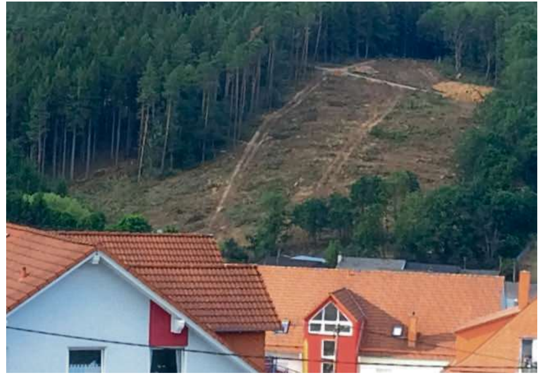
...mussten zahlreiche zerstörte Fichten gefällt werden.
