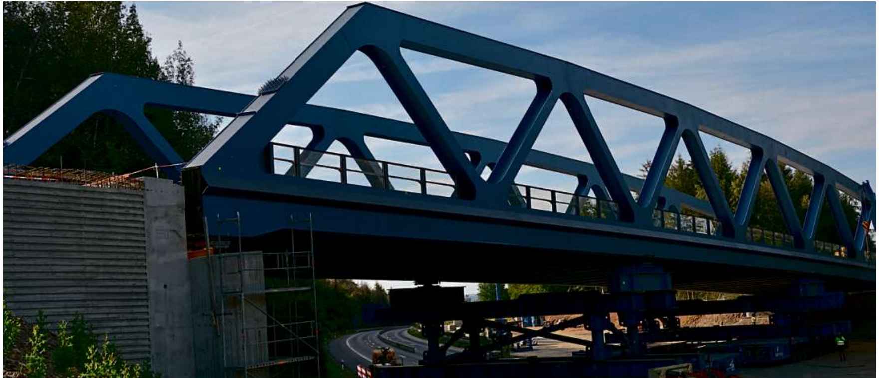
Die beiden Brücke sind an Ort und Stelle. Jetzt folgen noch einige Restarbeiten, dann kann im Herbst die B54 freigegeben werden.
