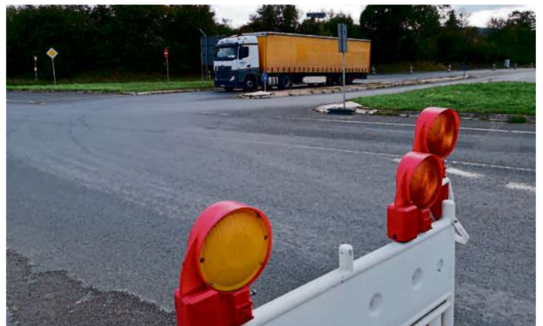
Auf der „Kalteiche“ wird ein Kreisverkehr gebaut. Foto: Ralf Triesch/Stadt Haiger
