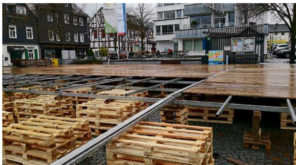
Seit Montag wird der Schwerlastboden aufgebaut. Anschließend kommen die Eislauf-Arena und die Verkaufshütten an die Reihe. Foto: Ralf Triesch/Stadt Haiger
