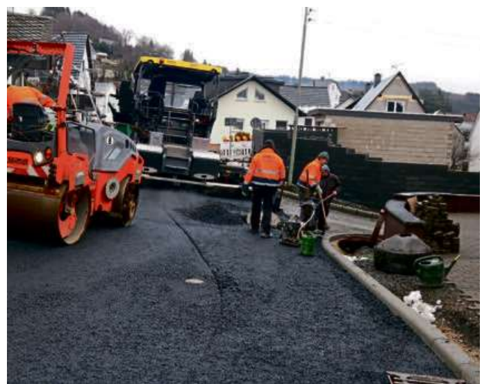
Mit einem großen Team ist die ausführende Firma dabei, die Asphaltierarbeiten voranzutreiben. Foto: Triesch/Stadt Haiger
