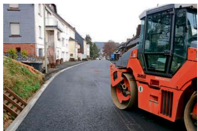
Bis zum Hirschweg wurde die Asphalt-Tragschicht hergestellt. Foto: Ralf Triesch/Stadt Haiger
