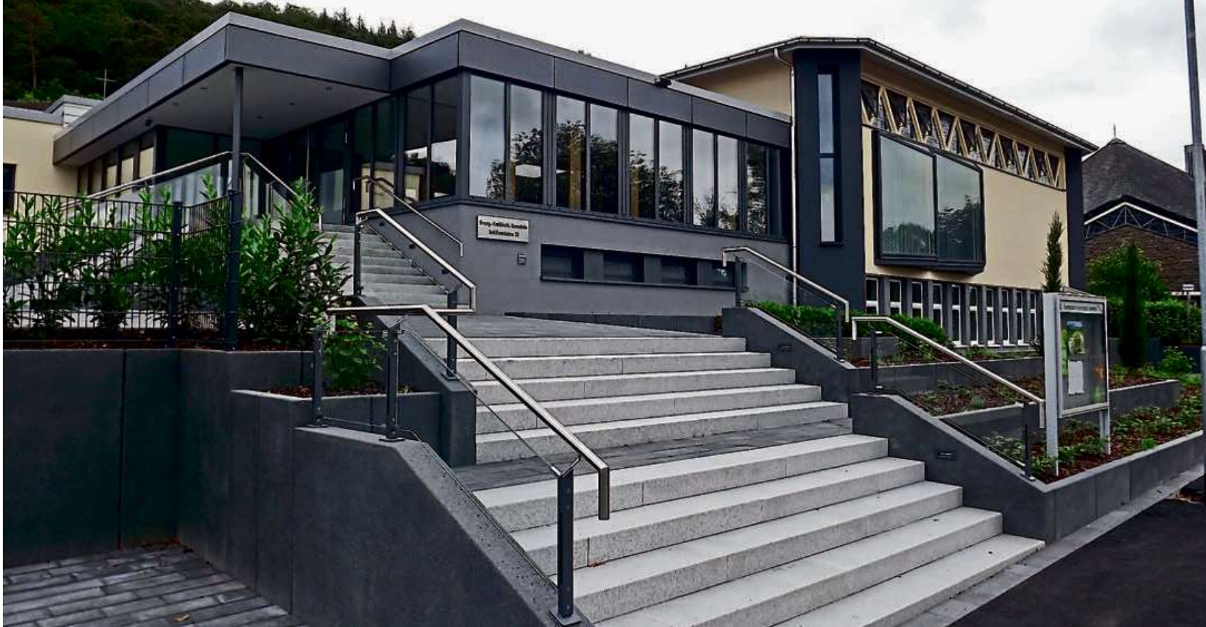
Die Evangelisch Freikirchliche Gemeinde Haiger (Schillerstraße).
