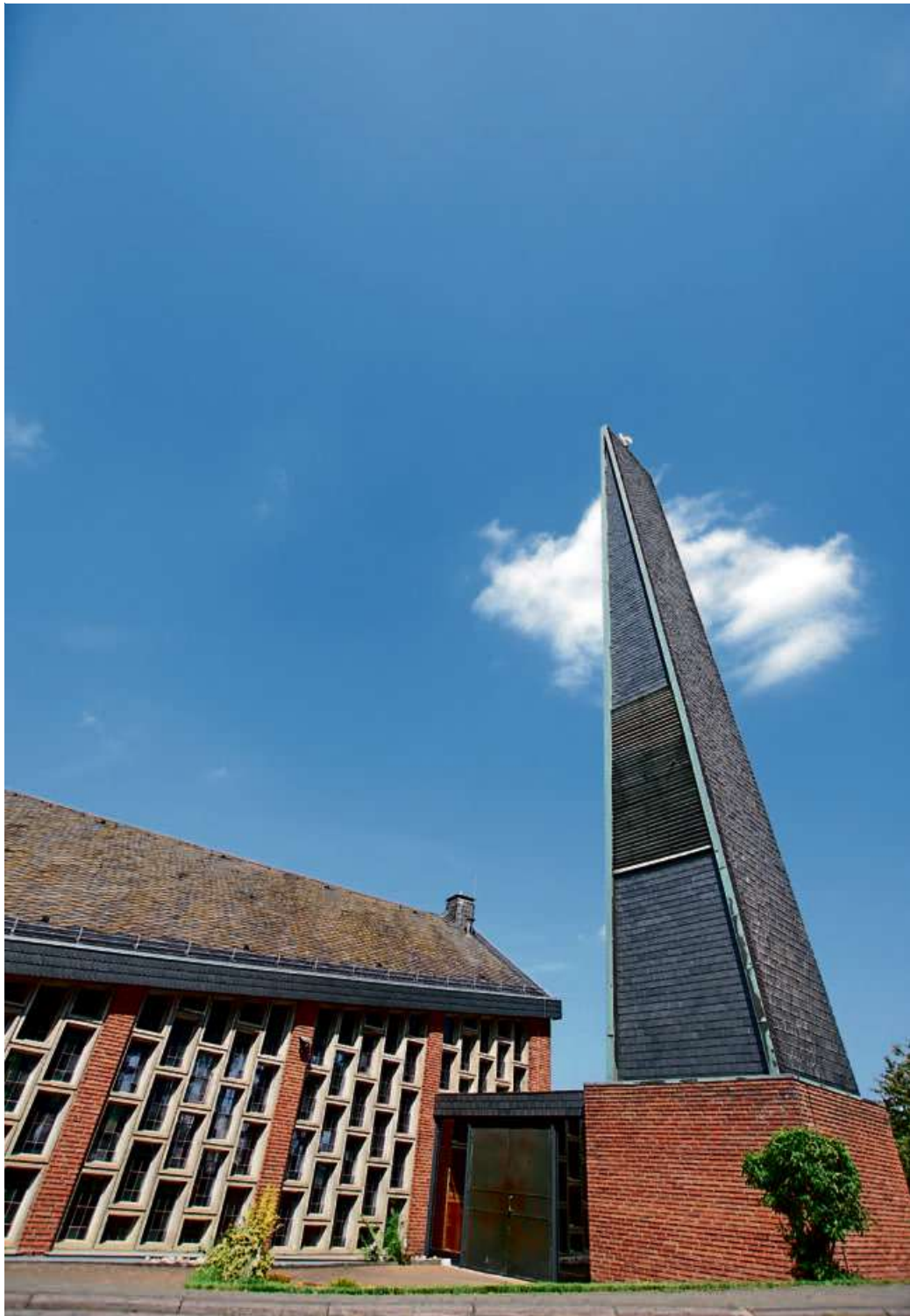
Die ev. Kirche in Langenaubach.
