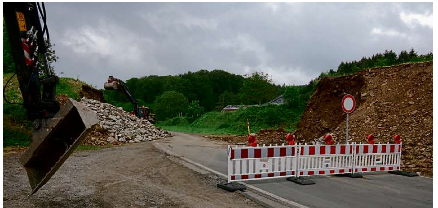
Anfang dieser Woche wurden in Langenaubach noch die Restarbeiten vorgenommen. Die Brücke, an der in der Vergangenheit der ein oder andere Lkw hängen geblieben war, ist Vergangenheit. Foto: Ralf Triesch/Stadt Haiger
