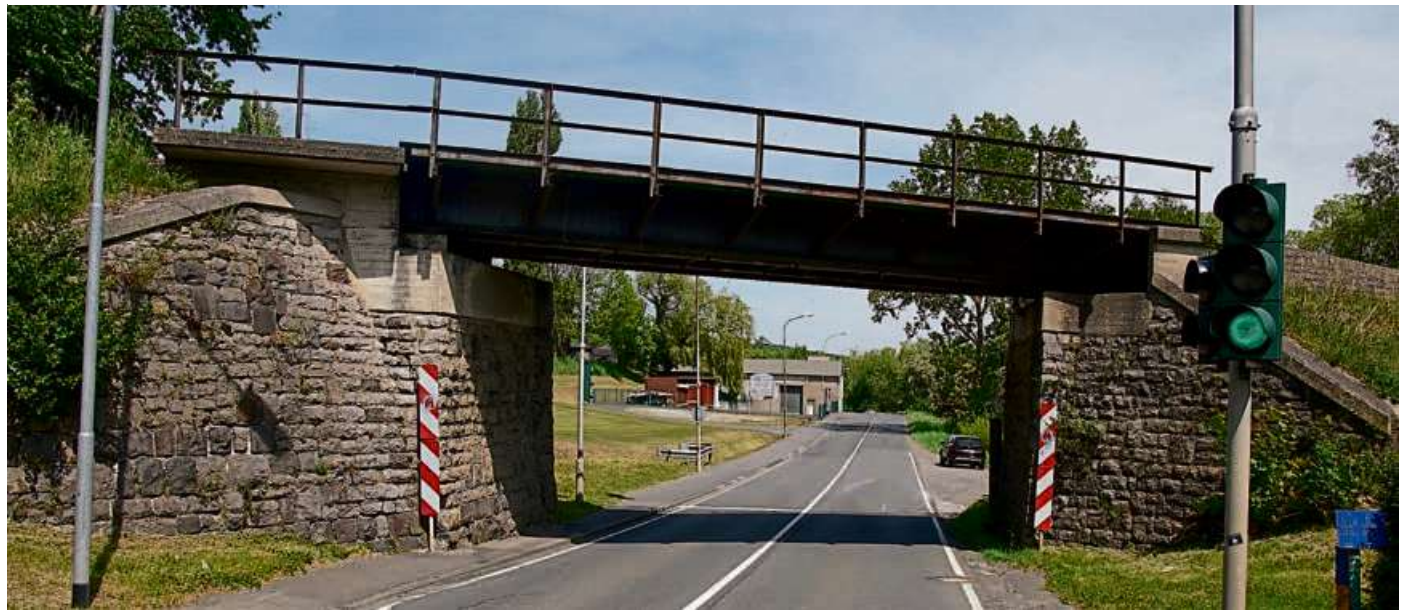
Auch die Westerwaldstraßen-Brücke wird im Moment beseitigt. Der Zugverkehr war schon vor vielen Jahren stillgelegt worden. Foto: Ralf Triesch/Stadt Haiger
