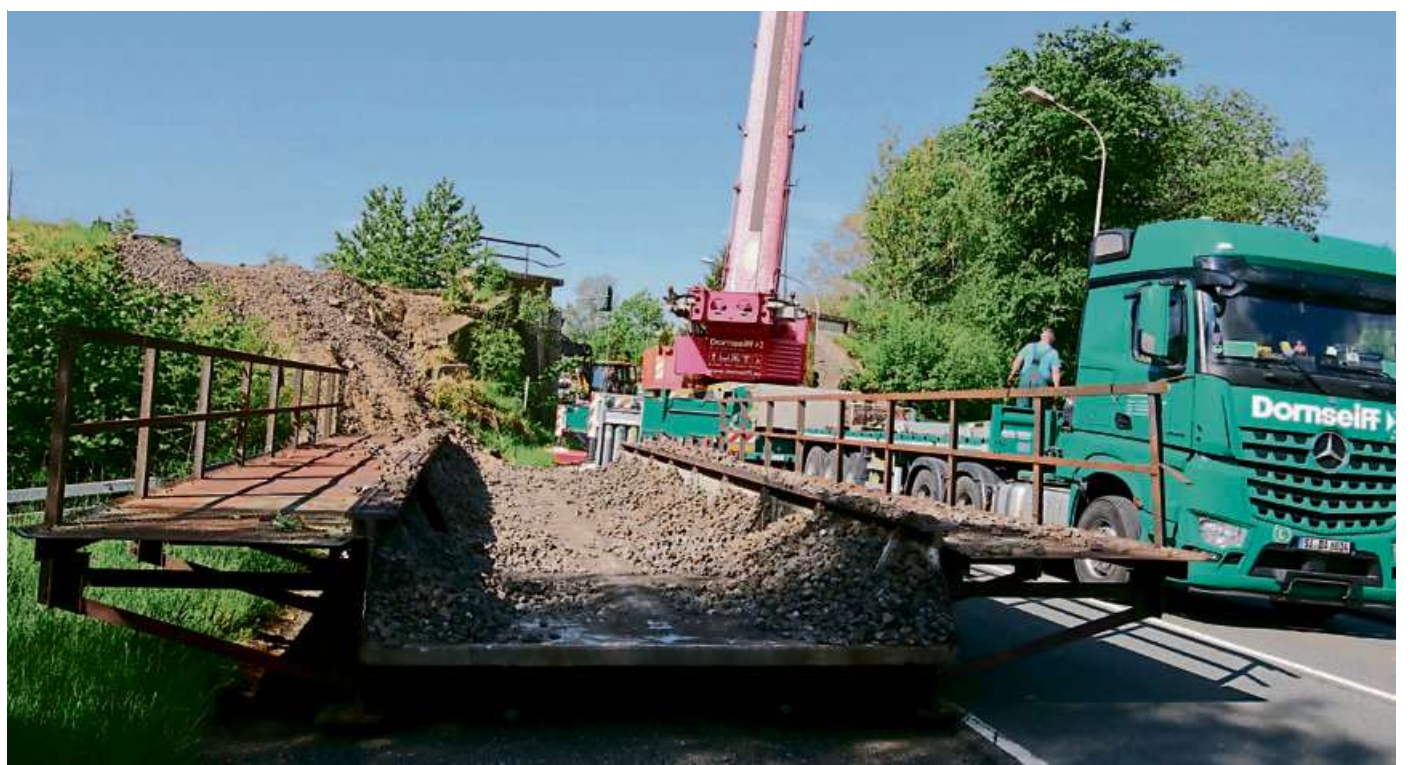
Mit einem großen Kran wurde der Überbau der Haigerer Westerwaldstraßen-Brücke am Dienstagmorgen abgehoben. Foto: Ralf Triesch/Stadt Haiger
